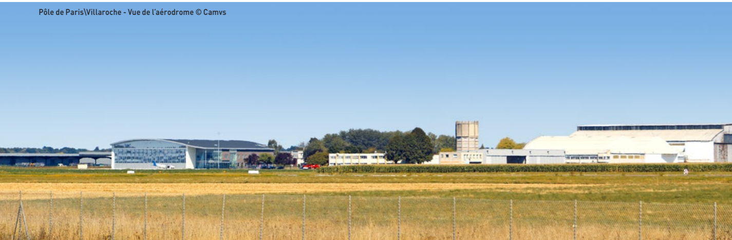
Pôle de ParisVillaroche - Vue de l'aérodrome © Camvs
